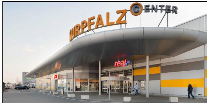
Mannheim (Kurpfalz Center) Spreewaldallee
