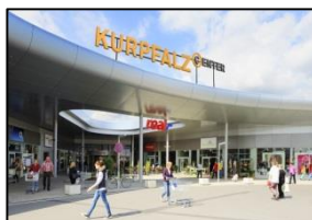
Mannheim Kurpfalz Center
